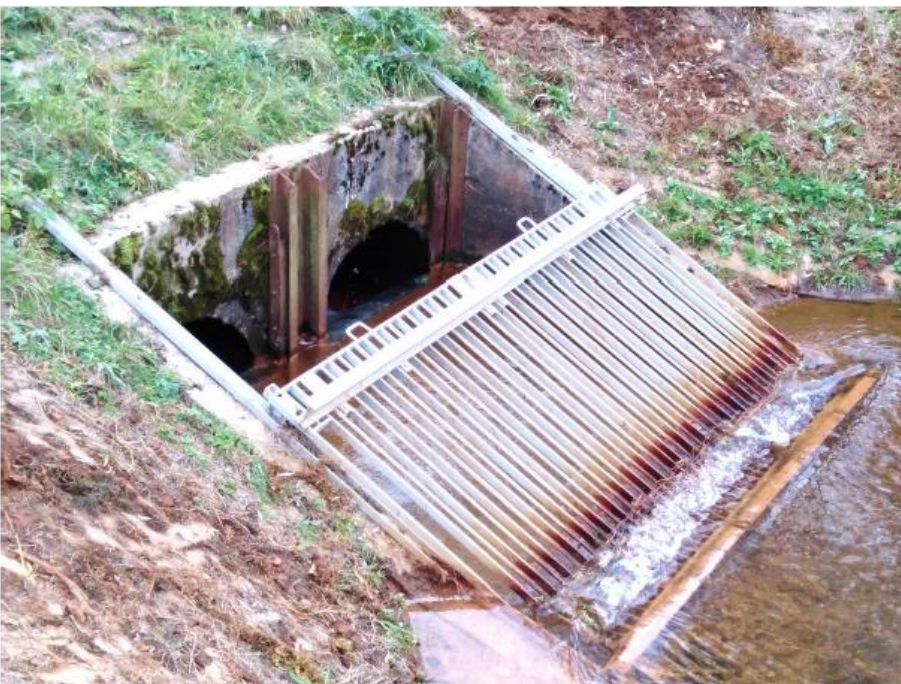
Przepust pod drogą rów B od strony napływu wód.
