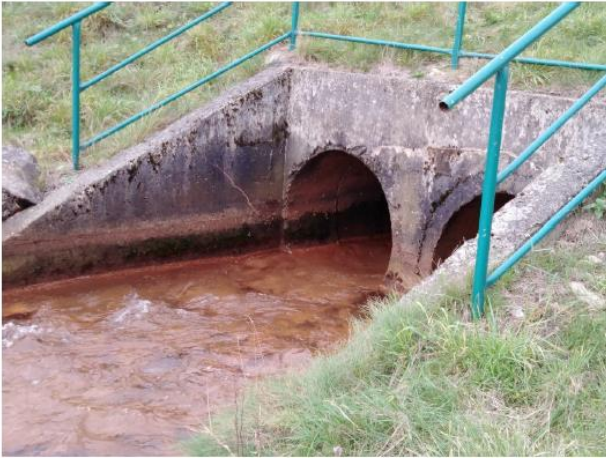
Przepust rów B
