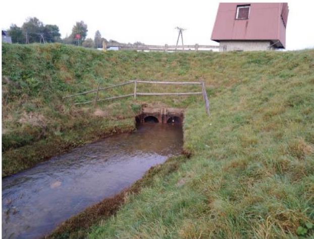
Przepust Rów C
