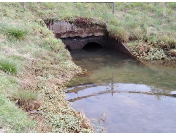
Przepust Rów C
