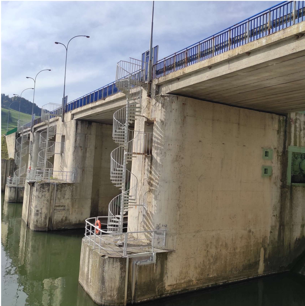
Fot . 1 i Widok od WD na filary jazu i konstrukcje mostu.
