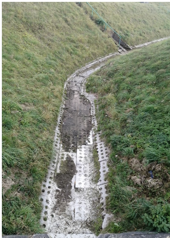
Fot.5 Rów C. Widok na rów od strony wlotu z zakresem uszczelnienia dna (do wylotu z drenażu)
