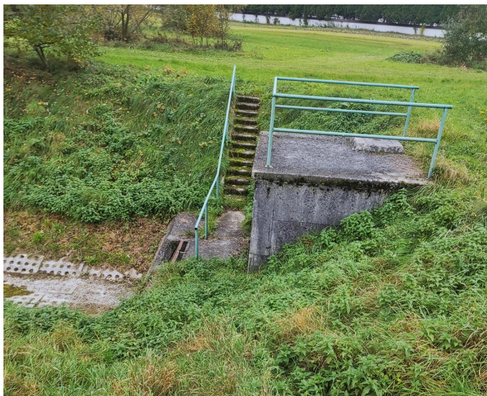
Fot.6 Rów C. Widok na wlot do studni przepadowej.
