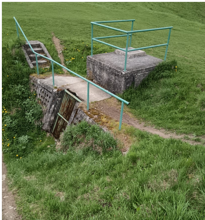
Fot.1 Rów B. Widok na wlot do studni przepadowej.
