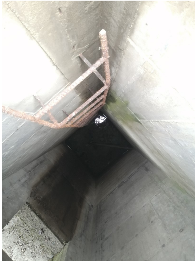
Fot.7 Rów C. Widok na wnętrze studni przepadowej.
